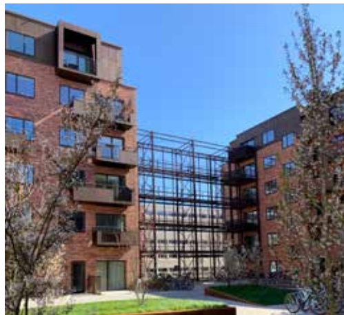
Støjskærm i malet stål med integrerede altaner, Valby Maskinfabrik (Vandkunsten)
